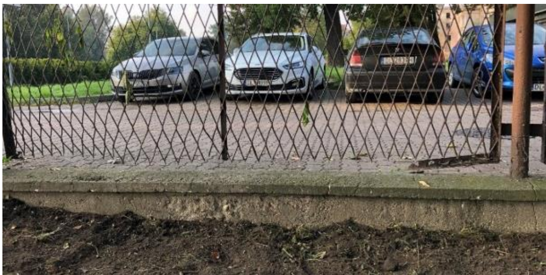
Fot. 5. Fragment podmurówki wzdłuż południowej granicy skweru z widocznymi pęknięciami oraz ubytkami tynku.
